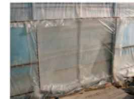
出入口を目張り
