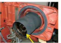
清掃前、スズで覆ったエアコン、デフューザーの状態
