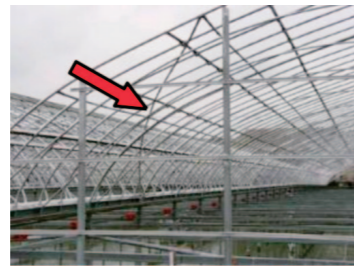
写真2 斜材(筋交いパイプ)による補強事例
