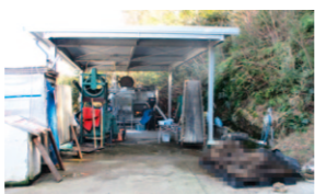
肥料原料用に処理する設備
