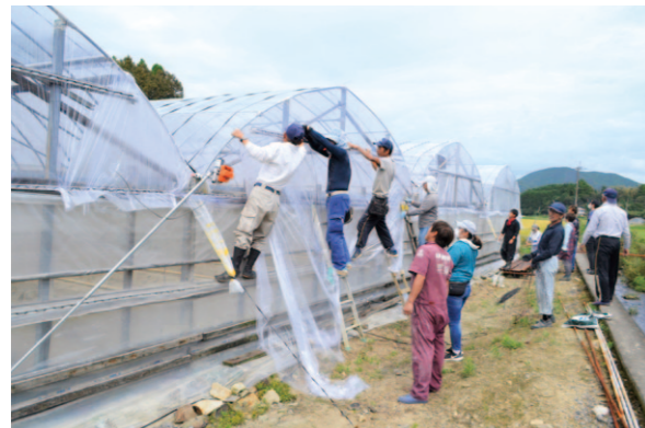
修復作業をする部員の皆さん。
