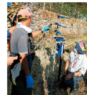
写真2 サル防護柵設置講習会
