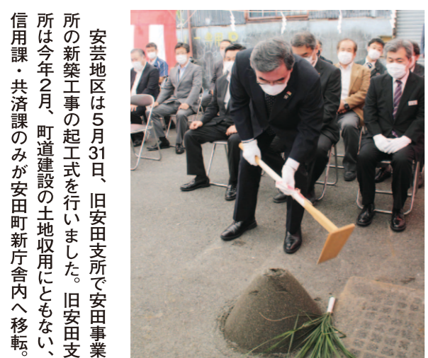
工事の安全を願って鍬入れをする秦泉寺雅一組合長
