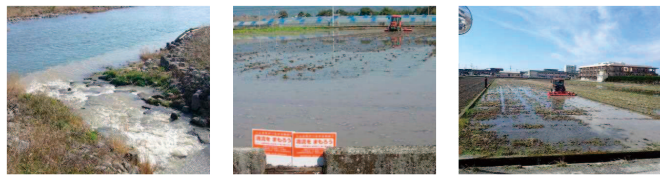
土壌を含んだ濁水の流出状況 止水板設置状況 浅水代かきの実施状況
