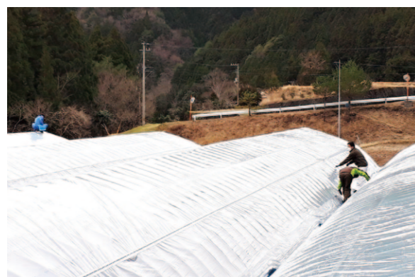
スムーズに被覆作業を行います
