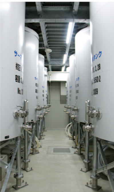
仕込み室。仕込みタンクの温度管理もデジタルで調整。24時間、最適な温度・湿度に管理されています。
