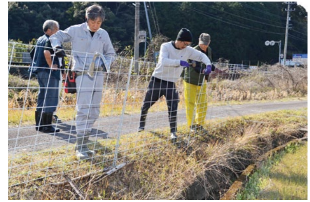
防護柵を設置する古津賀地区の住民ら
