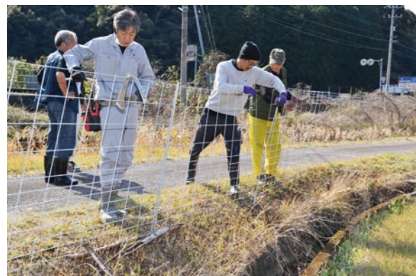
防護柵を設置する古津賀地区の住民ら
