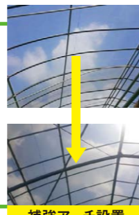
補強アーチ設置
