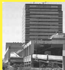
大阪事務所が入居する 大阪市中央卸売市場業務管理棟
